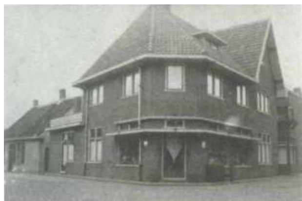
Het nieuwe winkel/woonhuis met daarachter het achterste gedeelte van het oude huis.
