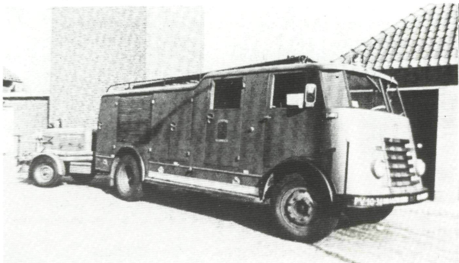
De DAF TMM brandweerwagen van Soerendonk met 6-cylinder Hercules motor (1974-1979)
